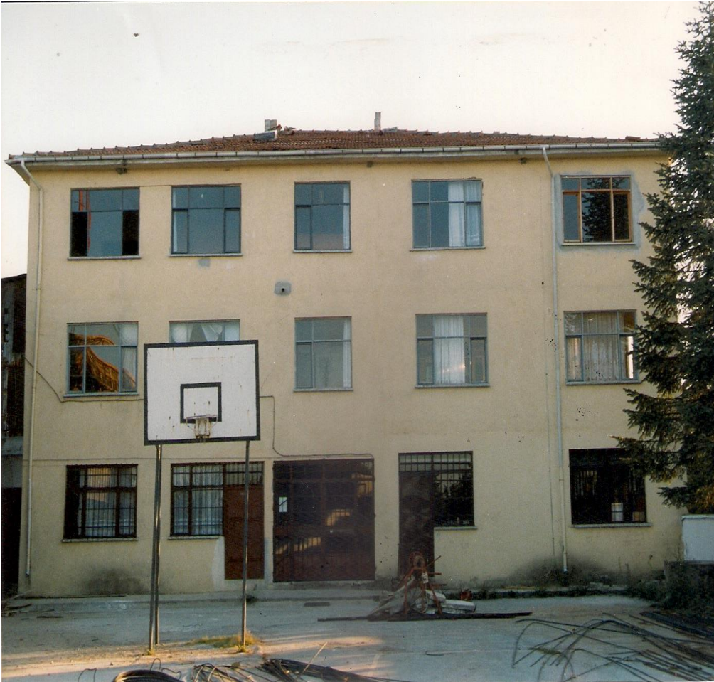
Okul ek bina yapımı.
